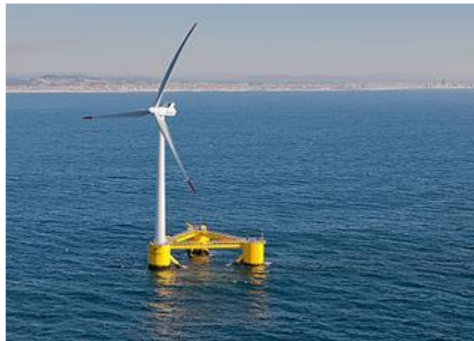
Fig. 7.04 Projeto WindFloat : Gerador eólico montado sobre plataforma flutuante ao largo de Aguçadoura. (by Untrakdrover / CC-BY-SA-3.0, via Wikimedia Commons)
