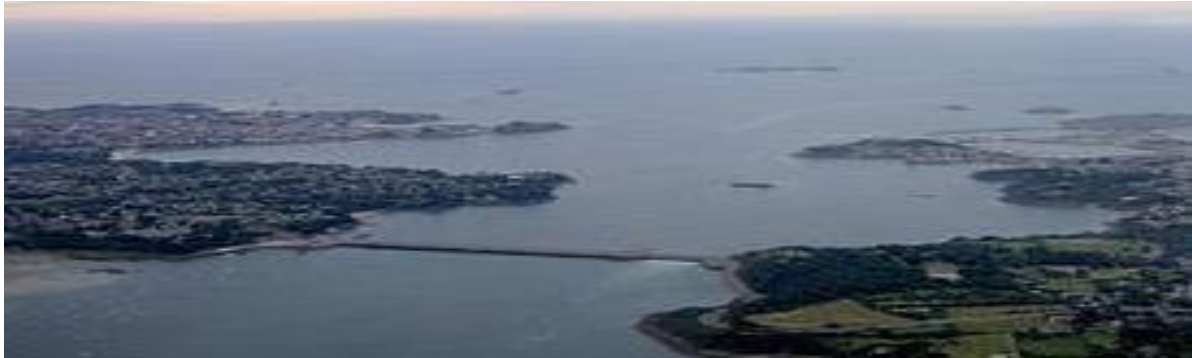
Fig. 7.06 Barragem de Maré de La Rance, França (via Wikimedia Commons).
